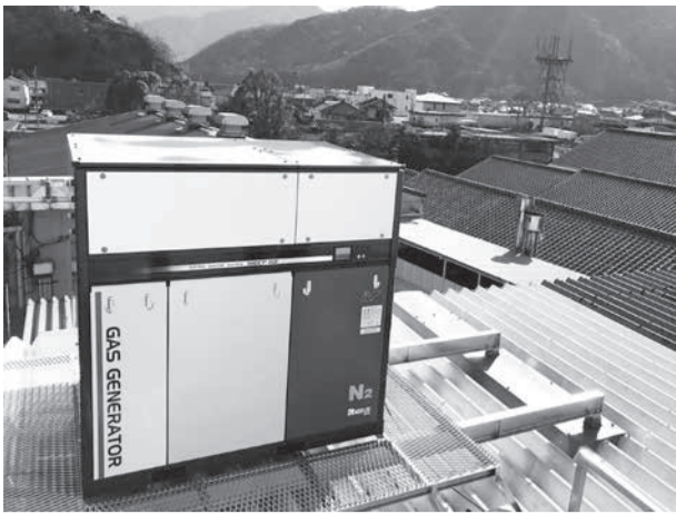
GENE-BASEシリーズ (窒素ガス発生装置) 屋外設置
