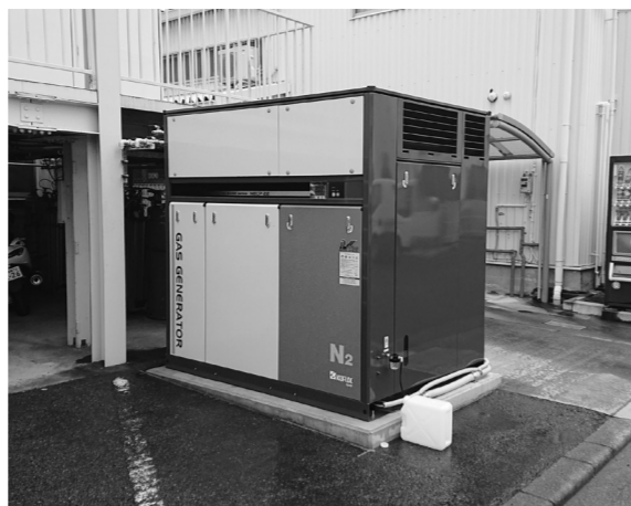
省エネ運転する「気筒休止システム」を備え、省エネ制御機能も進化した。窒素ガスと圧縮空気を同時に供給する場合、余剰の圧縮空気を工場エアとして追加供給が可能。工場全体の省エネに貢献する。圧縮空気の量は装置内で自動調整されるため、使い過ぎによるガス純度、露点の低下を起す心配もない。また、窒素ガスだけの単独供給の場合でも装置の消費電力を抑えた運転ができる。
